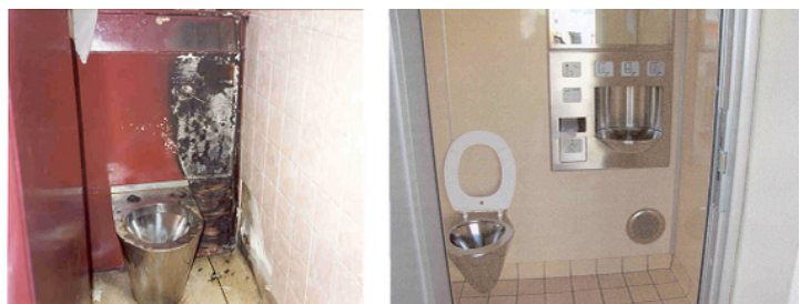
Den offentliga toaletten vid Starr Gate i Blackpool, före och efter renoveringen av Danfo.
